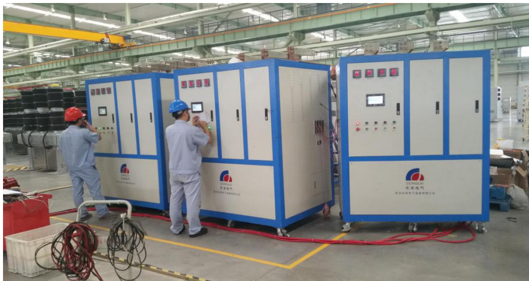
平高电气现场图片
